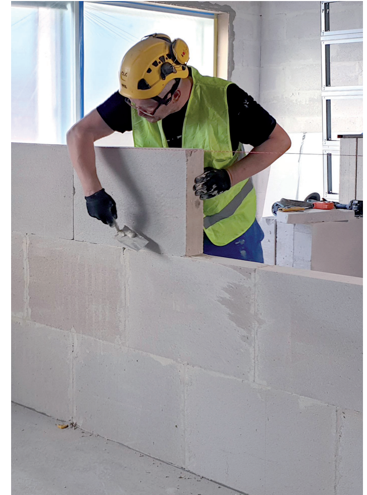
Kevyet väliseinät muurataan 100 mm kevytbetonilaatoista (kuvassa) ja kantavat väliseinät 200 mm kevytbetoniharkoista. Seinien vahvuudet esitetään arkkitehtikuvissa, koska niillä on vaikutusta tilaratkaisuihin.
