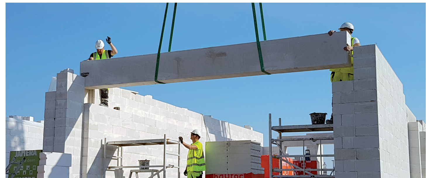
Kuvassa 600 mm kevytbetonipalkin asennus. Aukon maksimi leveys 600 mm palkilla on 5 400 mm.
